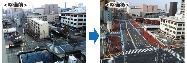
幹線道路の整備事例 (築港石城町線)
